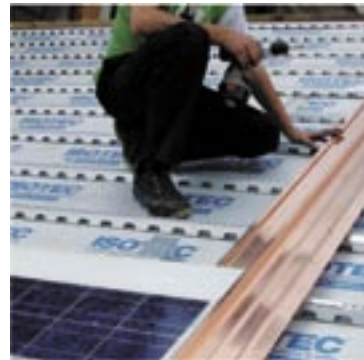
Posa prima scossalina laterale
